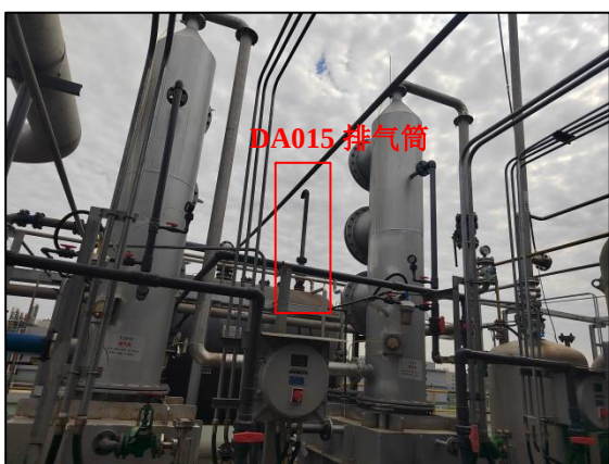
茚虫威车间含氢工艺废气处理措施
