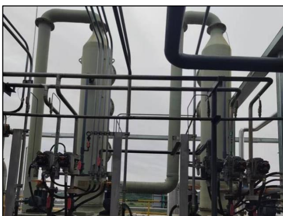
茚虫威车间工艺废气预处理措施
