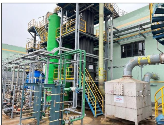
茚虫威车间含氢工艺废气处理措施
