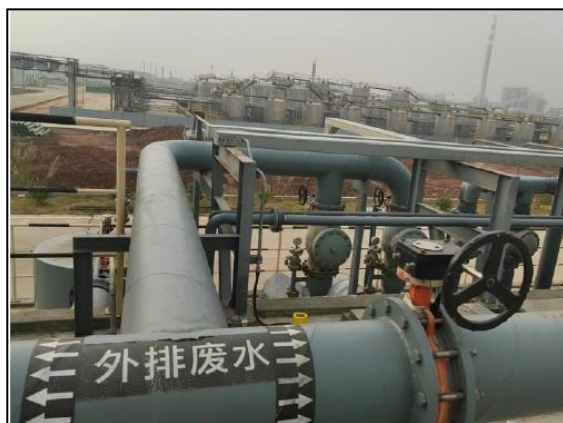
污水管网排口闸门
